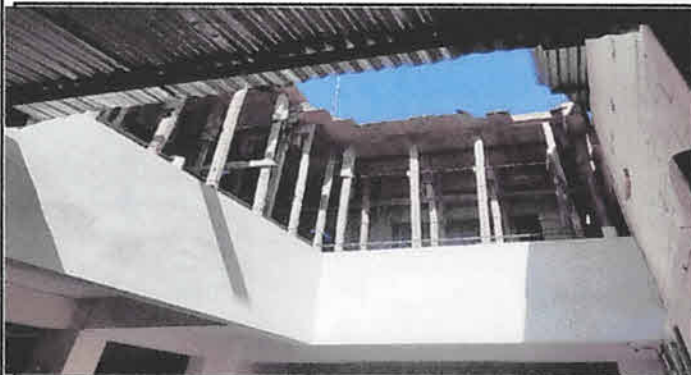
Foto: 3 Repello en paredes
