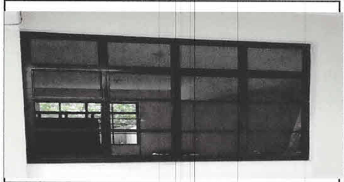
Foto 2: Instalacion de puertas y ventanas nivel 2
