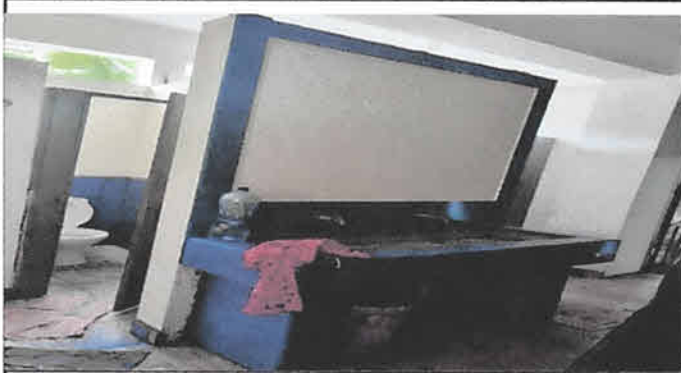
Foto1: INSTALACION DE AZULEJOS EN PAREDES DEL BAÑO
