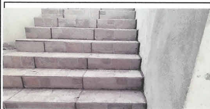
Instalacion de piso en gradas
